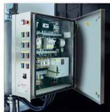
Quadro elettrico Electrical
